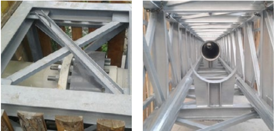
3.???? Giunto meccanico per assorbimento deformazioni assiali
