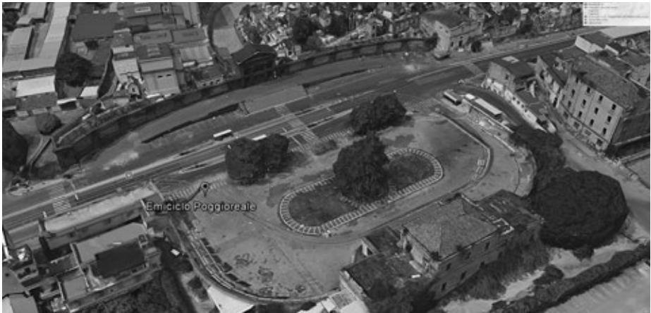
3.19 Vista dell’Emiciclo prima dell’inizio dei lavori. (Fonte: Google Earth 2017)
