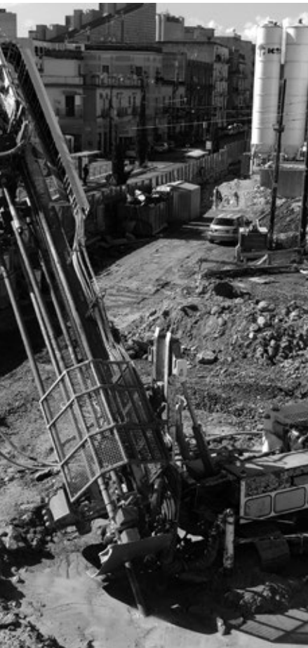
3.23 Esecuzione Jet inclinato. Consolidamento imbocco stazione.
